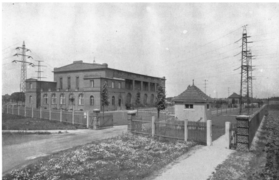
Bild 5: 110-kV-Schaltstation Friedrichsfelde bei Berlin
