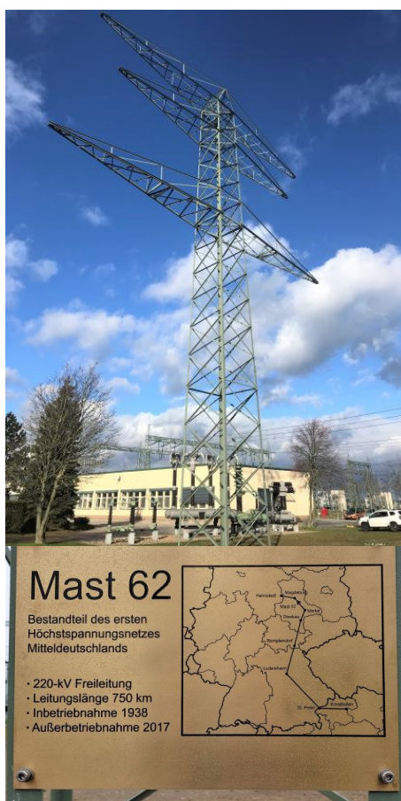
Bild 45: Mast 62 der ehem. 220-kV-Reichssammelschiene im UW Wolmirstedt (oben) mit Großaufnahme der dort angebrachten Gedenktafel (unten)
