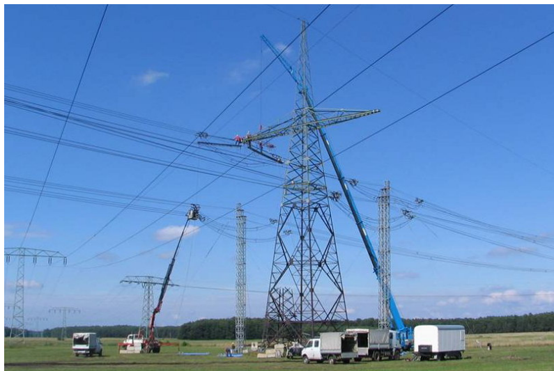
Bild 28: KTS-Grundinstandsetzung (KTS-GI) eines 380-kV-Mastes © VEAG
