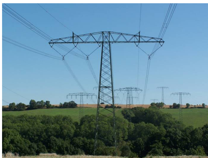
Bild 35: Ehem. 220-kV-Doppelleitung umgebaut zur 380-kV-Einfachleitung © VE Transmission
