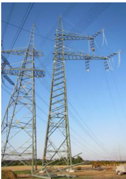
Bild 43: 380-kV-Leitungsneubau Bärwalde – Schmölln (links die alte und rechts die neue Leitung)
