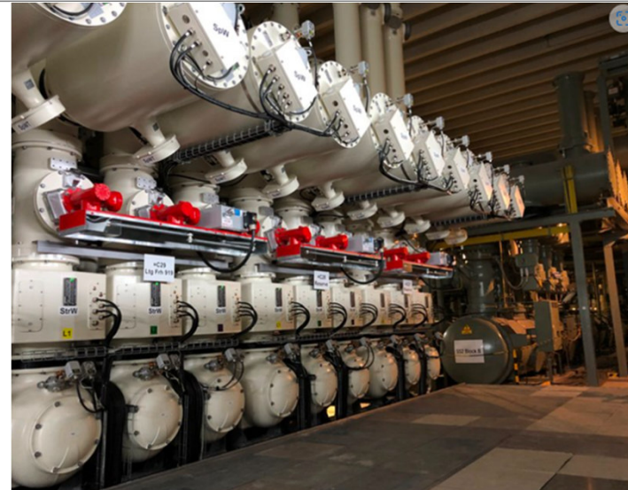
Bild 39: 380-kV-GIS-Neuanlage (vorn) und -Altanlage (hinten) mit Verbindung der Neuzur Altanlage im UW Mitte
