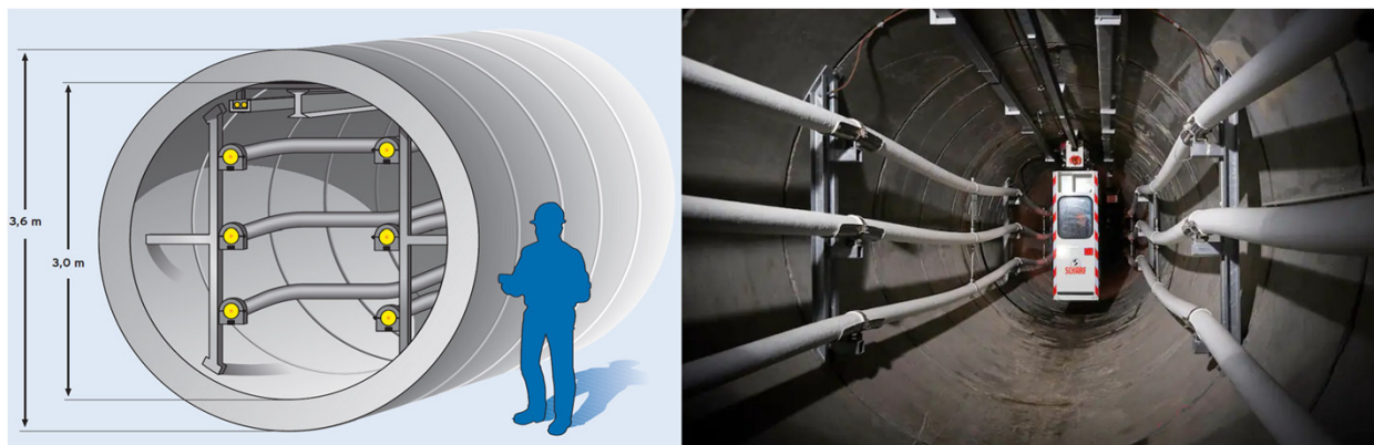
Bild 33.2: Kabeltunnel Mitte – Friedrichshain – Marzahn (linkes Bild) inkl. Tunnelbahn (rechtes Bild)
