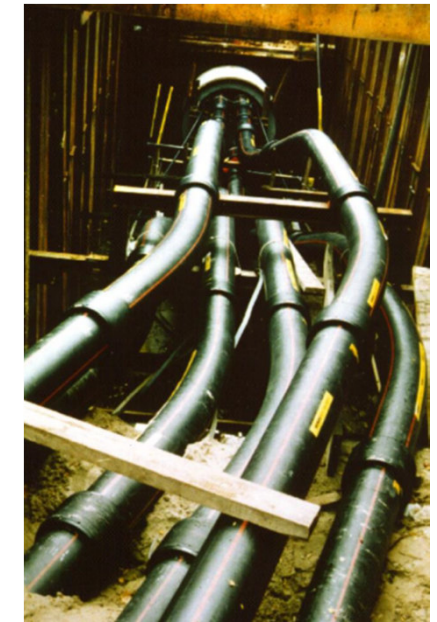
Bild 28: Anordnung der Erdverlegung (links) und PE-HD-Rohrlegung (rechts)
